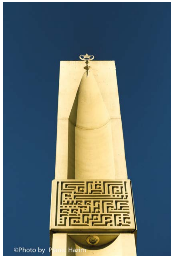
Die Islamische Gemeinschaft Stuttgart errichtete 2015 in Stuttgart-Wangen das erste Minarett der Stadt. Durch den 15 Meter hohen Turm erkennt man das Gemeindezentrum im Gegensatz zu vielen anderen Moscheen der Stadt schon von außen.
