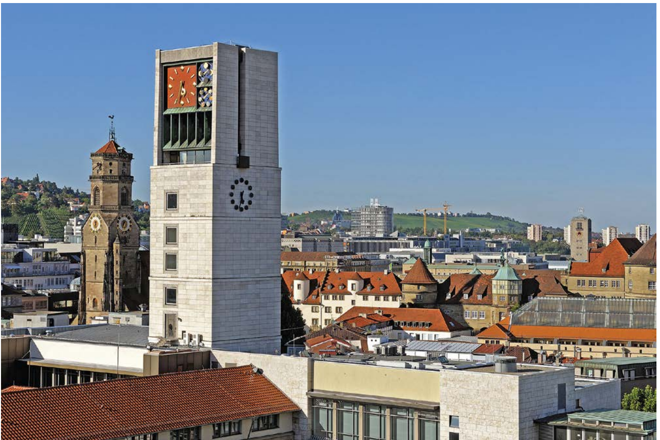
Über den Dächern von Stuttgart mit den Türmen der Stiftskirche, des Rathauses und der Domkirche St. Eberhard
